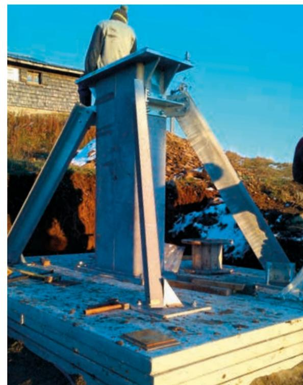
Les avantages sont indéniables notamment en terme d'impact environnemental, l'implantation et la mise en place sont rapides et les possibilités de déplacement, d'allongement ou de raccourcissement ultérieurs de la ligne très faciles : En une semaine, l'ensemble des ancrages d'un télésiège est réalisé.
