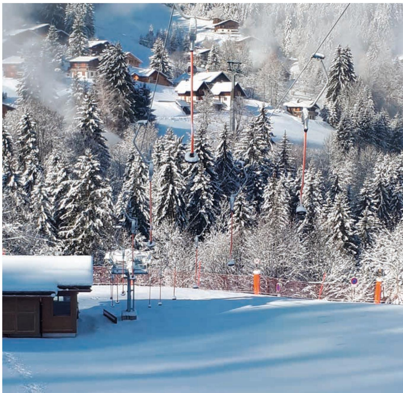
Les téléskis à enrouleurs ont la côte à La Clusaz et la station ne s'y est pas trompée que ce soit sur l'un ou l'autre secteur. S'adaptant à tout type de configuration, acceptant une variation de hauteur de neige importante sur la ligne, souple et confortable, affichant une fiabilité et une facilité d'entretien légendaires, c'est le matériel idéalement adapté aux front de neige ou aux zones débutants.
