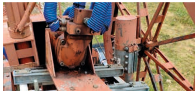
Groupe hydraulique remplacé par un moteur électrique capoté.
