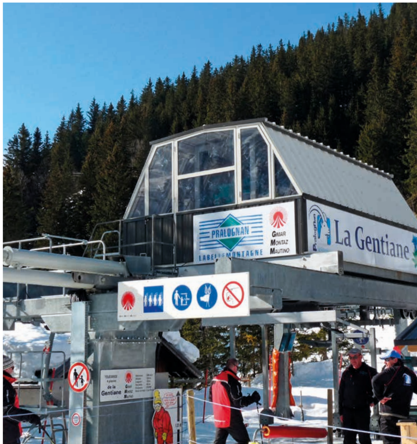
Télésiège de la Gentiane à Pralognan, anciennement télésiège de l'Oursière récupéré aux 7 Laux.
