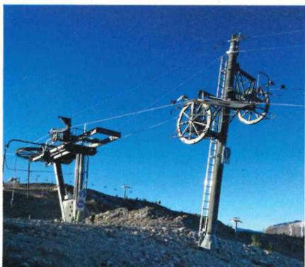
Superdévoluy, TK du Loup. Construction d'un télésiège débrayable avec ajout d'une station d'arrivée lâcher sous poulie récupérée à Chamrousse.
