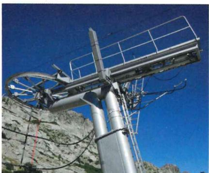
Ghisoni, TK du Capaghjolu. Rénovation du télésiège débrayable en place, et mise en place d'un lâcher sous poulie provenant du télésiège du Morel à Valmorel.
