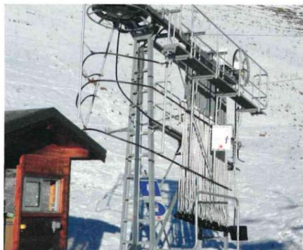
Aurès, TK du Col. Rénovation du télésiège débrayable en place. Récupération de la station motrice. Ligne avec pylône d'angle et gare d'arrivée neuves.
