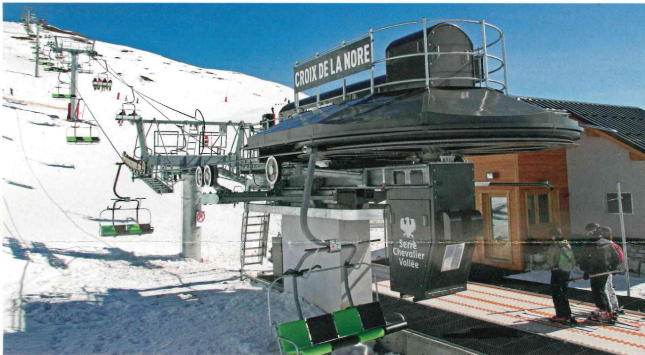
La Mi7 est certes la petite dernière, elle n'en est pas moins performante et optimisée. Elle ne craint pas les intempéries : les éléments de freinages et la poulie motrice, à la voie, sont entièrement recouverts par un large capot qui les protège.
