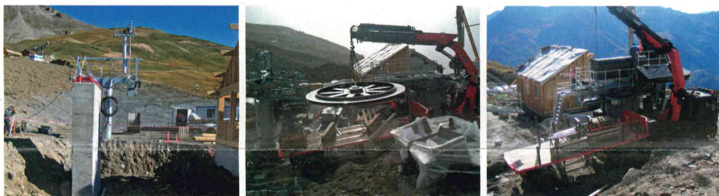
Génie-civil de ligne et gare.
