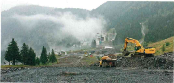
Les travaux de réaménagement.
