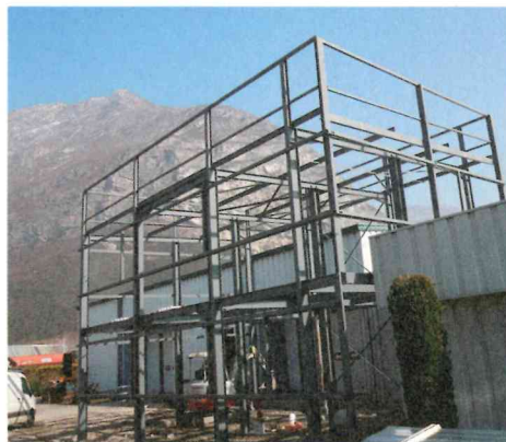
Construction de la structure de l'extension.
