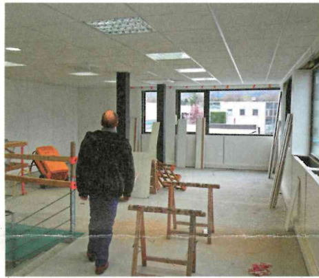
Nouveaux locaux : les travaux avancent...
