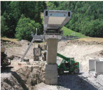
Pré-montée en atelier, la superstructure de la gare motrice/tension 7+ est assemblée en 2 jours.
